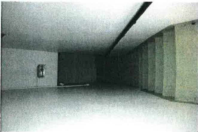
269. Lämpökeskuksen rakenteet on valettu betonista. Sinne laskeutuu kapea porras kellarikerroksesta.
