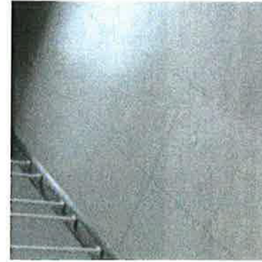
215. Vanhan sairaalan porrashuoneen harmaata vinyyli- ja vinyylimattoja.
