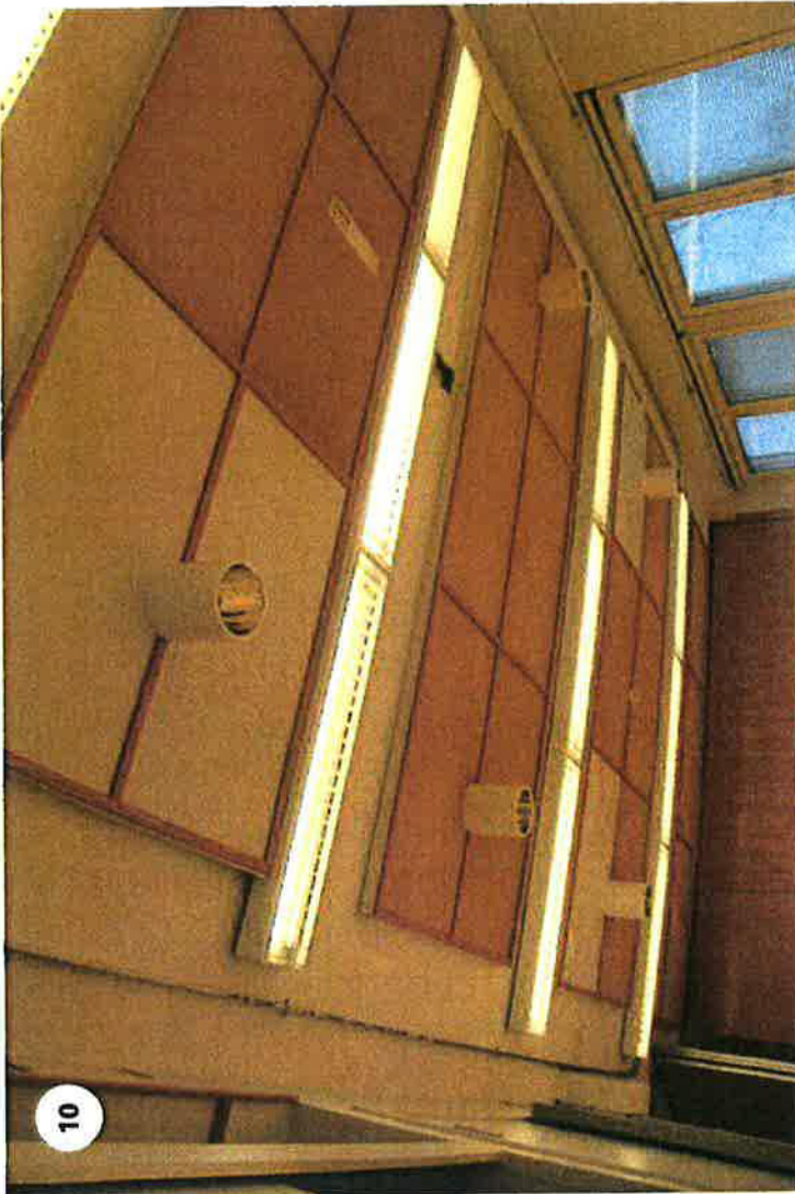
338. Luentosalin alakatossa vuorottelevat eri sävyiset akustoivat elementit ja erilaiset valaisimet.
