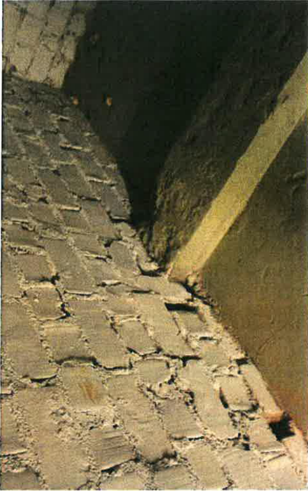
159. Alkuperäistä tiiliseinää vanhan osan hissistornissa. Keskellä on alkuperäisen yläpohjalaatan vahvikepalkki.
