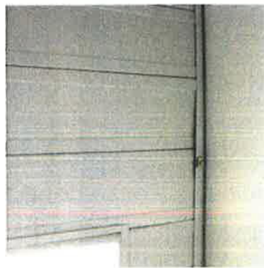
220. Teräsrunkoon kiinnitetty teräspröfiili käytävästä.
