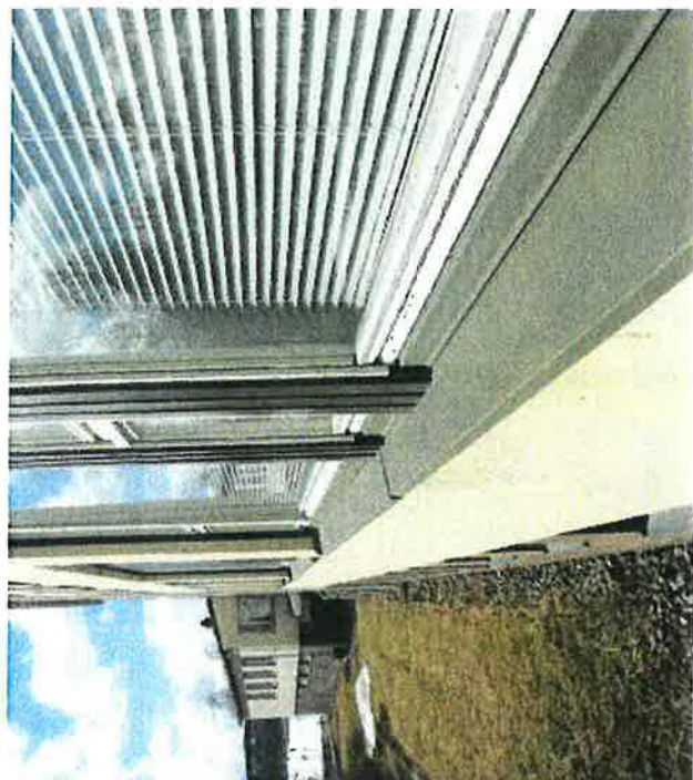
201. C-siiven toimenpidehuoneiden ikkunanauhaa rytmittävät kapea ruskea peiterimoitus ja kapea tuuletusikkunalla varustettu pystyikkuna.
