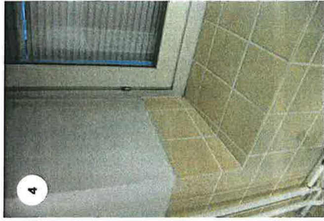
277. Suihkuhuoneen ikkunapenkki on laatoitettu.
