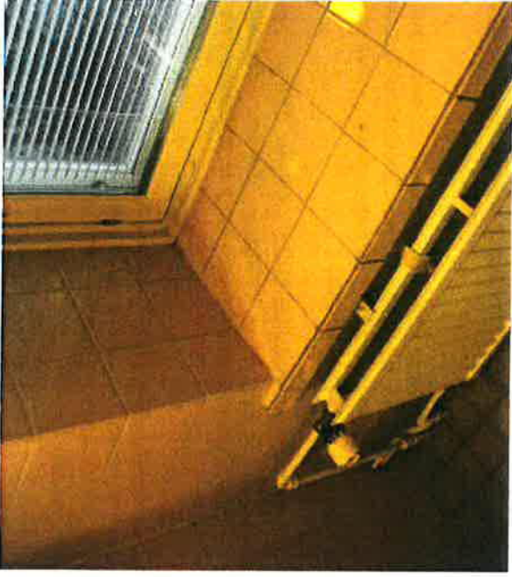
401. Pesuhuoneen laatoitettu ikkunapenkki on leveä.
