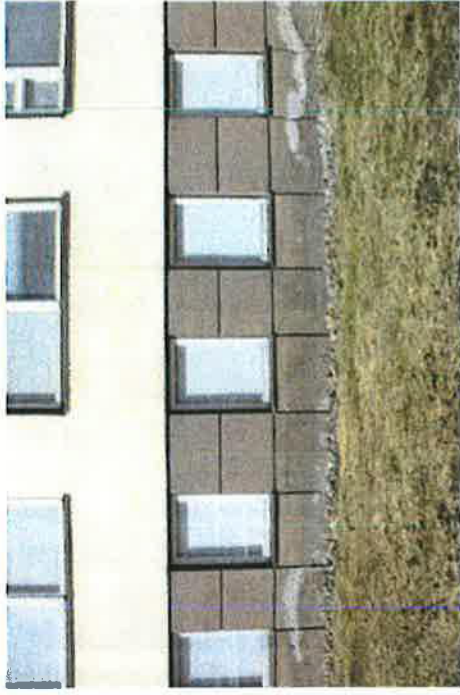
151. Laajennusosan sisäpihan puoleinen kivijalassa on tasarytmisen aukotus. Kivijalka on betonia ja maalattu ruskeaksi.
