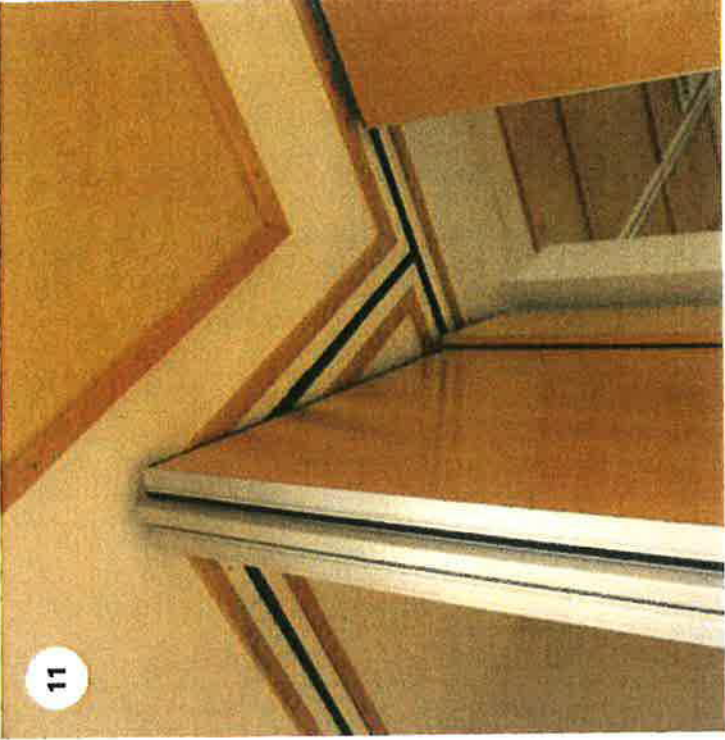
339. Taiteoven kiskomekanismia katossa.
