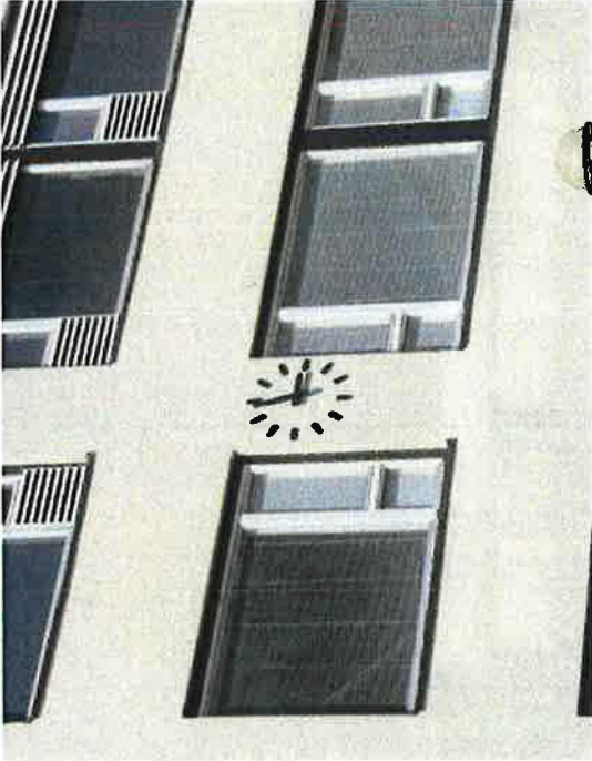
147. C-siiven länteen avautuva julkisivu on aukotettu suurilla ikkunoilla. Aukotuksen rytmi vaihtelee yksittäisten ikkunoiden ja ikkunaparien kesken.
