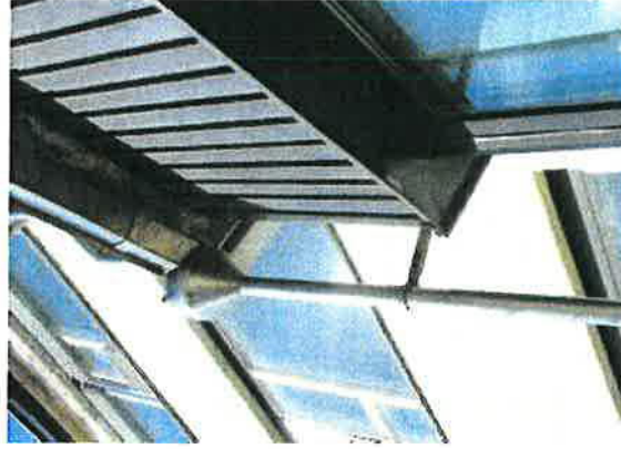
179. Pääaulan laajennuksen ruostumattomasta teräksestä tehty suppilo ja syöksy.
