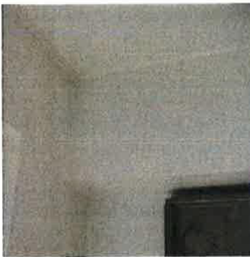
245. Tasoitettu ja maalattu tiiliseinä A-siivessä.
