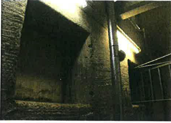
364. Entisen halkovaraston lattialaatasta on kellariin johtavat pudotusaukot.
