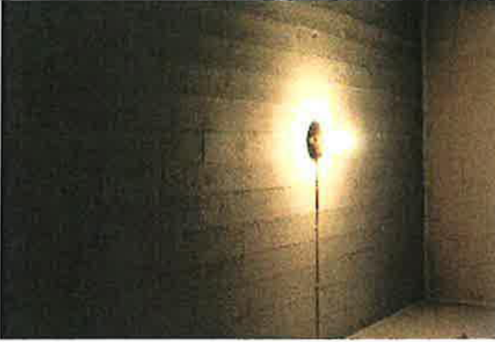
354. Autotallin betonista valettu sisäkatto.
