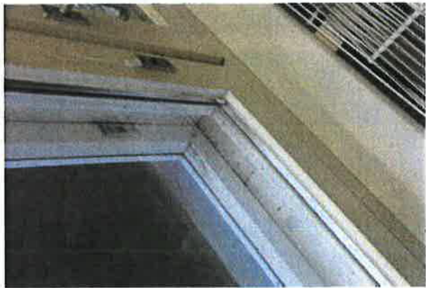
195. Etelään ja länteen suuntautuneet ikkunat on pääsääntöisesti uusittu 1990-luvun peruskorjauksessa. Sisemmässä puitteessa on lämpöläsi.
