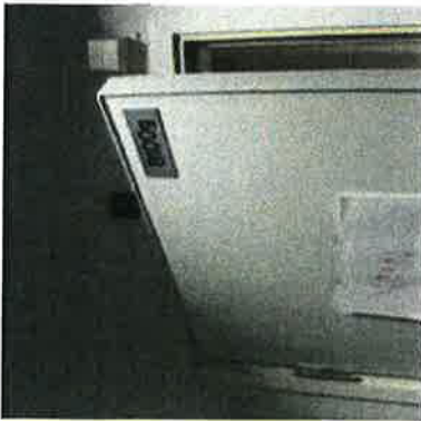
230. Perusovi on laminaattipintainen ja reunavahvistettu alumiinilistalla.
