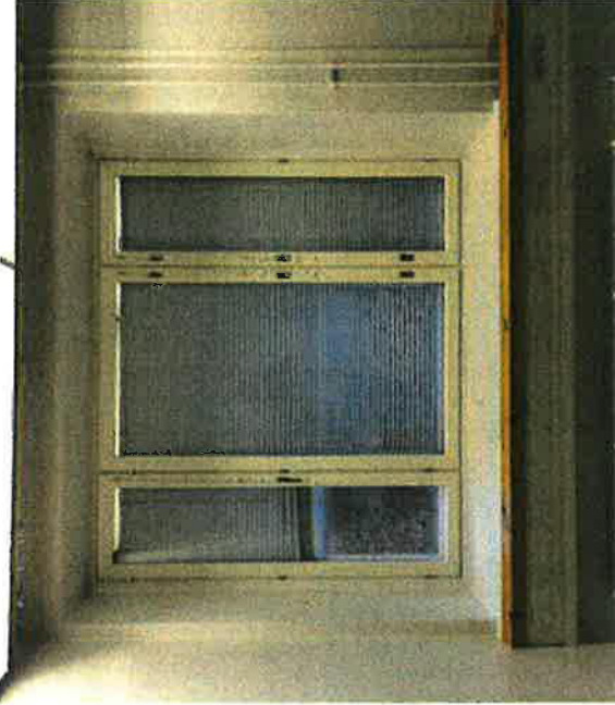
386. Olohuoneen ikkuna on muodoltaan ja puitejaoiltaan alkupe- räinen.
