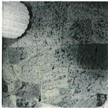
211. Keskusaulan harmaa kivilaattalattia.
