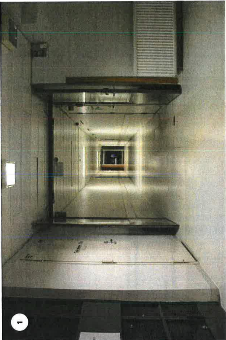
274. Sairaalan vanhimman osan kellarikäytävän näkymä hissien kohdalta itään. Tilat sijoittuvat keskuskäytävän molemmin puolin.
