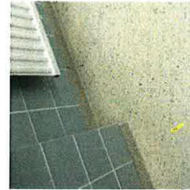
210. Tyypillinen toimenpidehuoneen vinyylimatto, jossa on kitkapinta. Vastaavaa on käytetty saniteettitiloissa.
