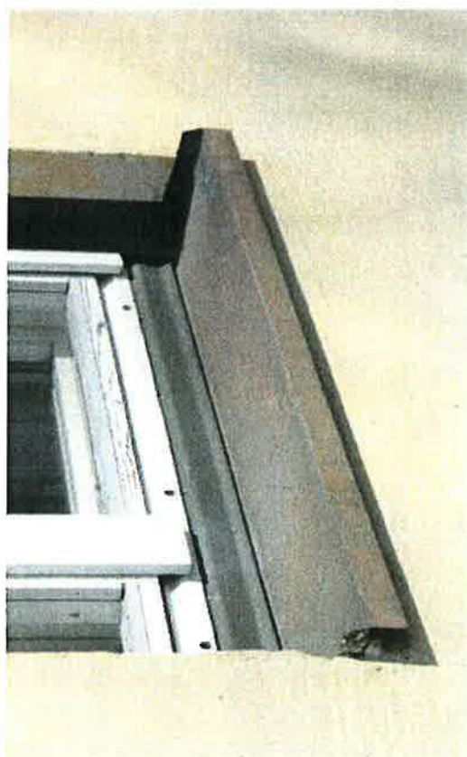
200. Ikkunoissa on loivasti eteenpäin kallistuvat vesipellit. Ne on maalattu ruskeiksi.
