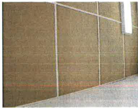
225. Teräksiseen ripustusjärjestelmään ladottu akustoiva kasettikatto.
