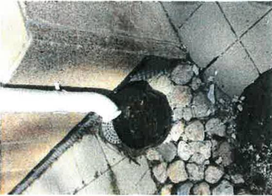
177. A-siiven kaakkoiskulmalla on muovinen loiskekuppi ja seinässä patolevy.
