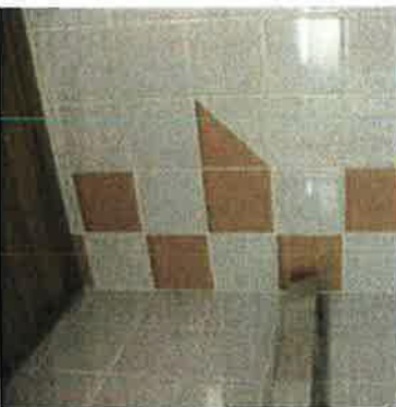
247. Potilashuoneen WC:iden tyyppilistä laattakuviointia.
