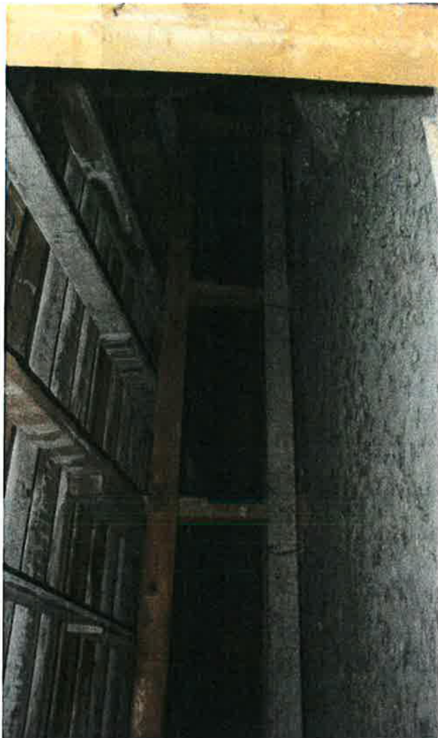
165. 1960-luvun vesikattorakennettä B-siivessä. Aluskatteena käytetty puutavaraa on käytetty aiemmin valumuottina. Yläpohjaan on puhallettu lisäeristettä.
