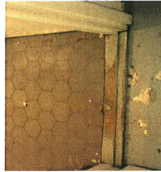
358. Saniteetitilassa on alkuperäinen kuusikulmainen lattialaatta. Kynnys on monen käyttäjän kuluttama.
