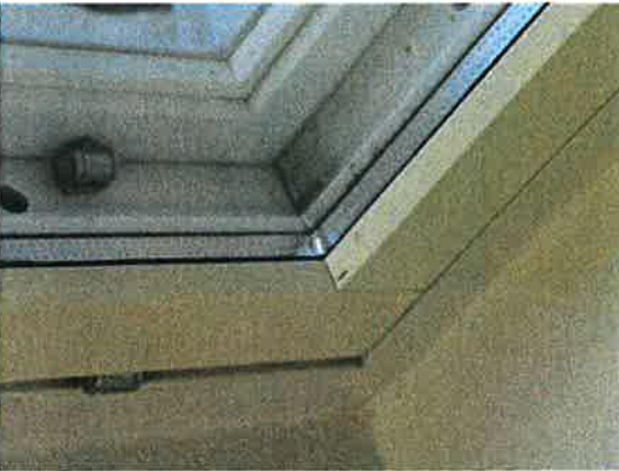
385. Ikkunat on uusittu 2000-luvulla.
