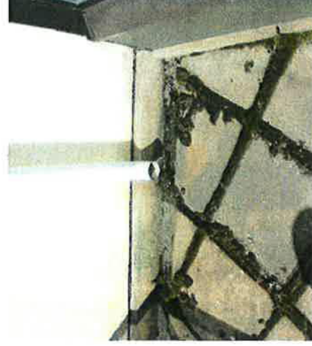
181. C-siivessä sadevesi laskeutuu seinustan betonilaatoitukselle.
