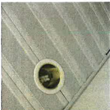
224. Käytävän ja keskusaulan alumiini-nen rei'itetty K-paneelikatto.
