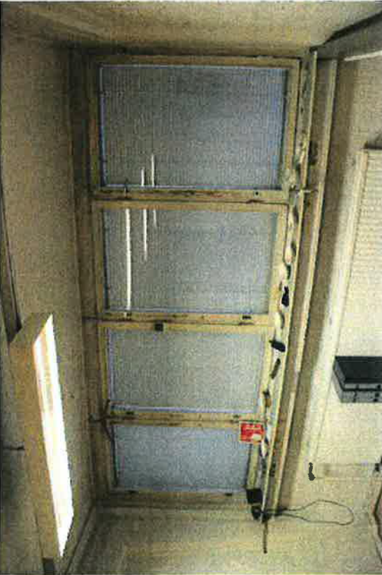
353. Ereläosan neljän ikkunan rivi on alkuperäinen. Rakennuksen keskiosan ikkunat on lisätty myöhemmin.
