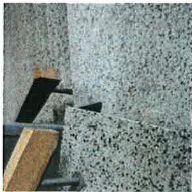
214. C-rapun mosaiikkibetonilattia on 1960-luvulta.
