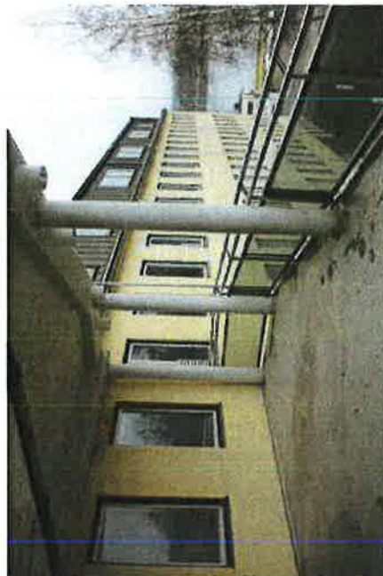
175. Keskusaulaan liittyvät suuret oleskeluparvekkeet on tuettu pyöreillä betonipilareilla. Kaide on terästä ja säilytettyä lasia.
