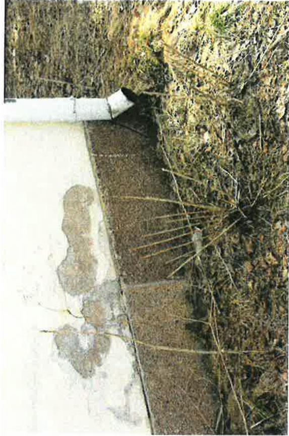
375. Matala sokkel on terastirapattu ja siinä on harmaat pystysaummat.
