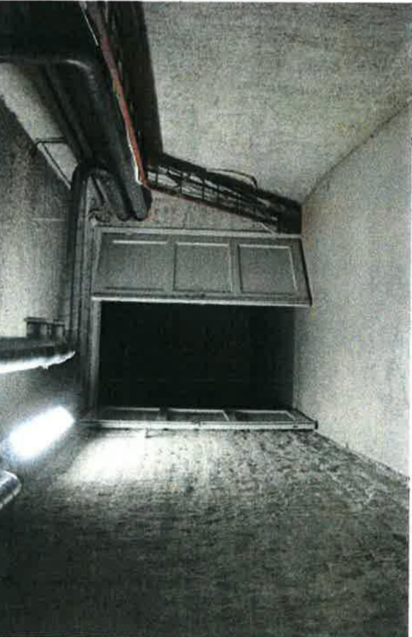
360. Sairaalan kellarista lähtevä maanalainen tunneli päättyy huoltorakennuksen kellariin. Kuvassa näkyvät puuovet ovat alkuperäiset. 1960-luvun puiset peiliövet
