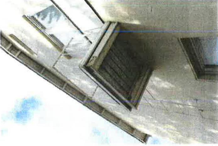
368. Parveketta kannattaa kaksi betonipalkkia. Parvekkeen pinnakaide on muodoltaan alukepäinen.
