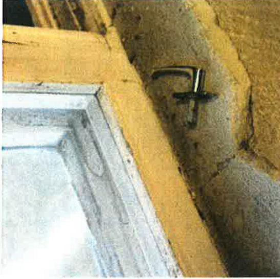
355. Alkuperäinen kaksilasinen puuikkuna.
