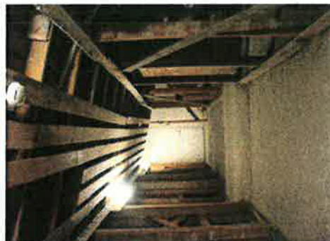
168. Pohjoissiiven ullakotilaa keskikäytävän kohdalla.
