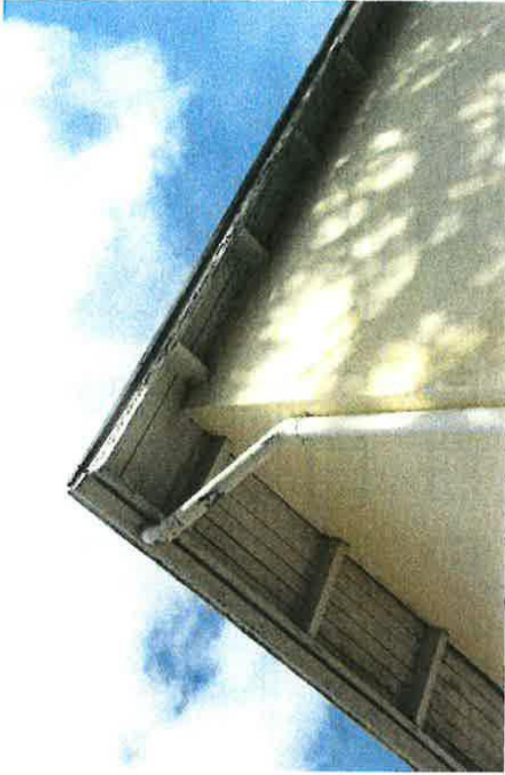
374. Vesikatto tuuletuu räystäältä. Ullakon tuuletusta on tehostettu rakennuksen päissä.
