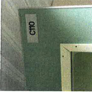
232. Ikkunallinen toimenpidehuoneen ovi.
