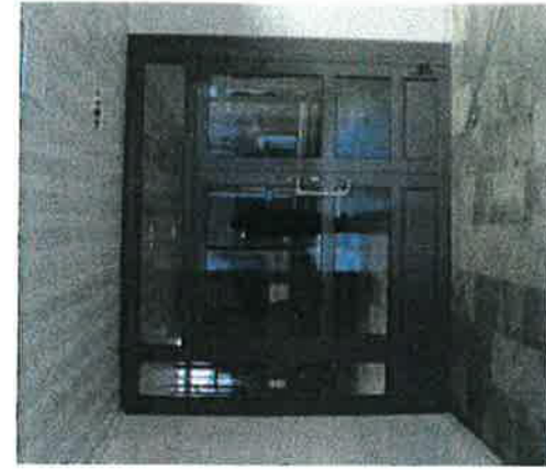
236. Alumiinirunkoinen palo-ovi B-siiven ja keskusaulan välillä.
