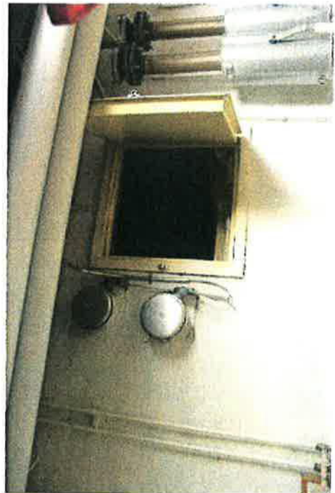
272. Siipirakennusten alla kulkeva tunneli on matala ryömintätie. Siellä kulkee eristetyt lämpö ja vesiputket sekä viemärit.
