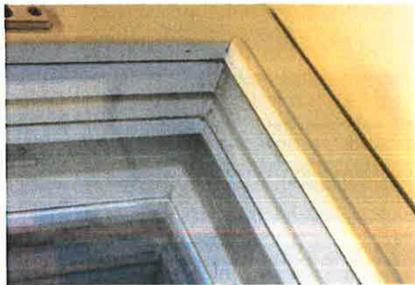
194. Pohjoiseen ja itään suuntautuneet ikkunat ovat tyypillisesti 1960-luvun puuikkunoita, joissa kolmas lasi on omassa puitteessaan.
