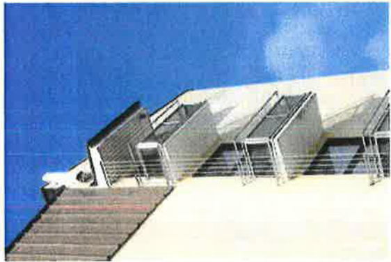
169. A-siiven itäpäädyn uusitut parvekkeet
