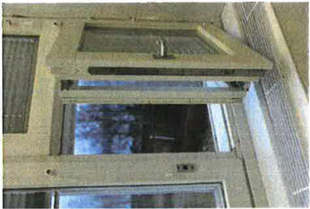
196. Potilashuoneiden ikkunoissa on myöhemmin uusitut tuuletusikkunat.
