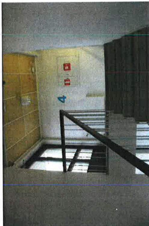
261. Portaan profiili on siro. Kaiteen metallipinnat on kiinnitetty askelmiin pareittain. Käsijohde on puuta.
