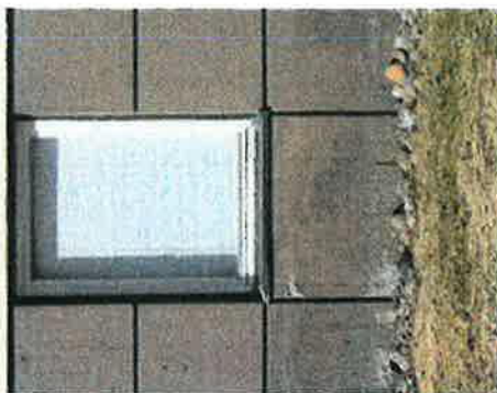
204. C-siiven kellarin ikkuna sisäpihan suuntaan. Ikkunapuite on siro.
