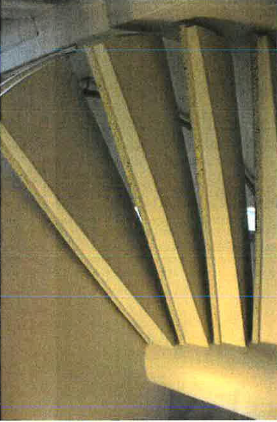
381. Porras on tehty tehdasvalmisteisista elementeistä. Askelmissa on mosaiikkibetonipinta.
