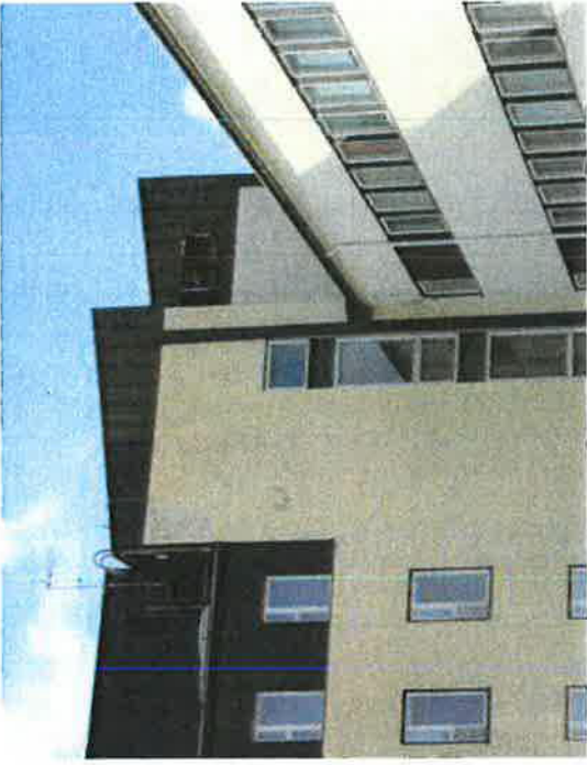
148. Vanhan sairaalan ruudukkomainen aukotus ja laajennusosan nauhaikkuna kohtaavat sisäkulmassa. Liitymäkohdassa on porrashuoneen pystysuuntainen ikkunanauha.
