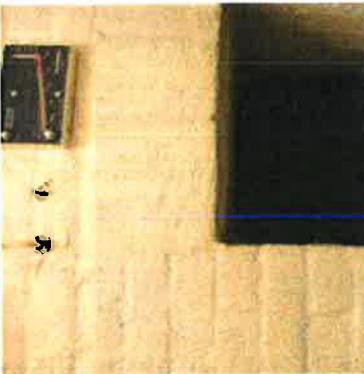
246. Muurattu ja slamattu seinä kellarissa.
