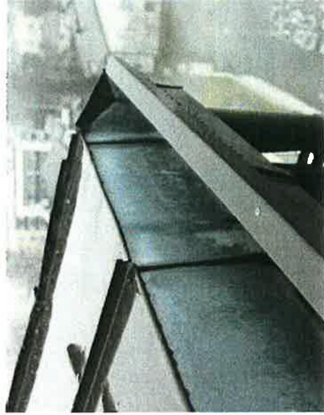
157. Vesikaton ja vesikourun liittymä B-siiven päädyssä.
