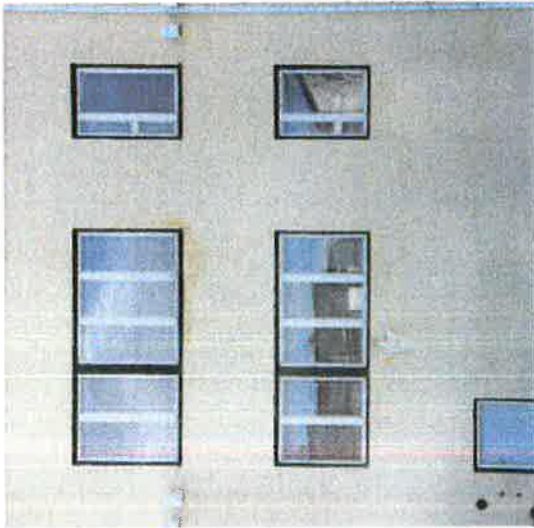
146. Vanhan sairaalan pohjoisjulkisivun keskellä on ruudukkojaosta poikkeavat viiden ikkunan yhdistelmät. Niiden kohdalla oli alun perin leikkaussalit.
