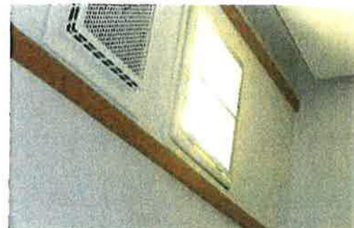
251. Tyypillinen toimenpidehuoneen uppovalaisin.
