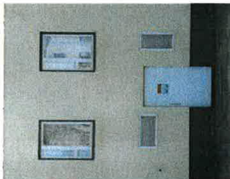
192. Tekniseen tilaan johtava huoltoovi.
