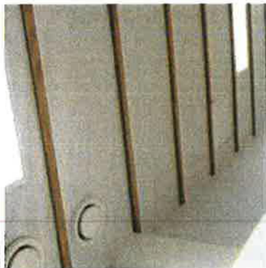
222. Potilashuoneissa ja kokoon-tu-mistiloissa on rimoituksella rytmitetty levykatto.
