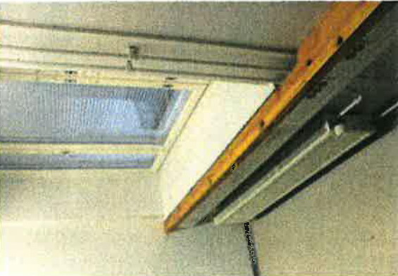
384. Ikkunapenkissä on mäntyistä.
