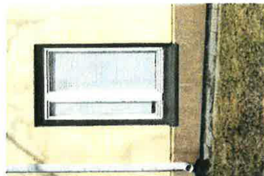
201. C-siiven toimenpidehuoneiden ikkunanauhaa rytmittävät kapea ruskea peiterimoitus ja kapea tuuletusikkunalla varustettu pystyikkuna.
